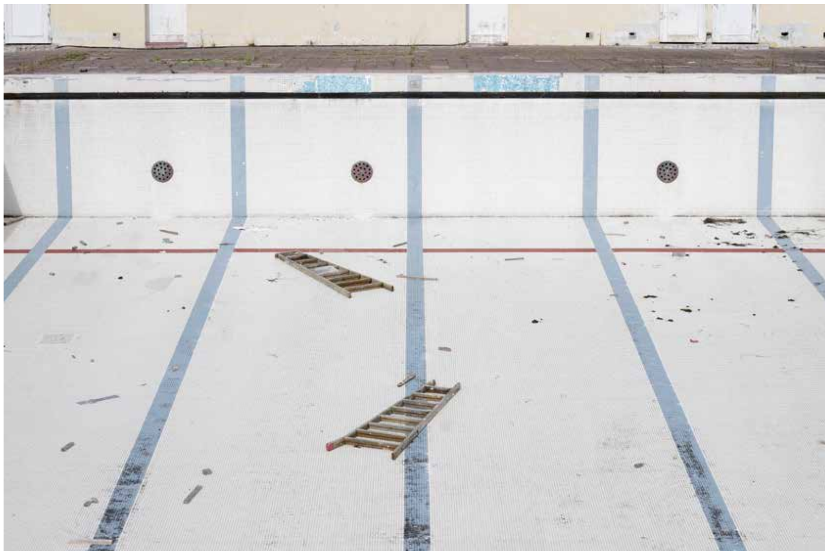
La piscine #8033 photographie numérique, octobre 2021
